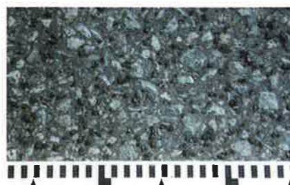
ゴム粒子が突出したルビット舗装の表面
