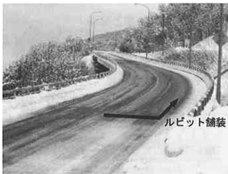
写真-2 ルビット舗装の凍結抑制効果
