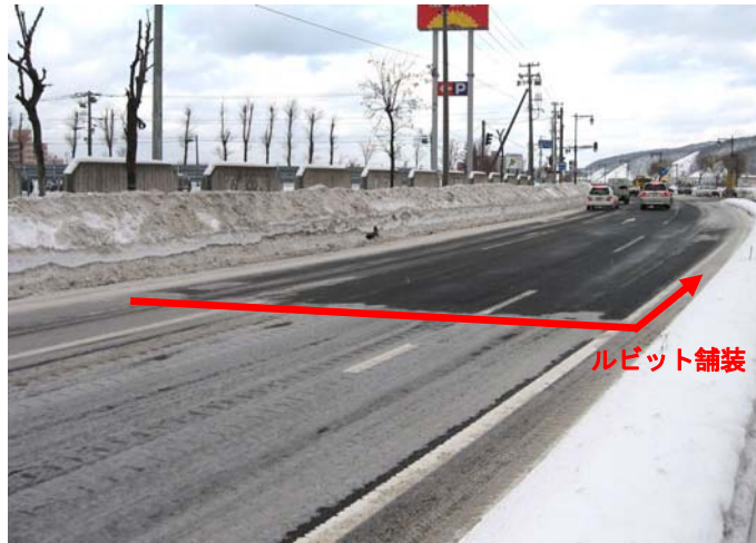
写真-1 ルビット舗装の凍結抑制効果（北海道の国道）
